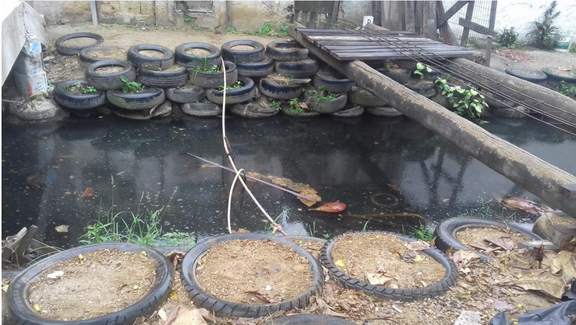
FIGURA 58 - CONTENÇÃO DE PNEUS NAS MARGENS DO RIO JACARÉ FEITA POR MORADORES LOCAIS
