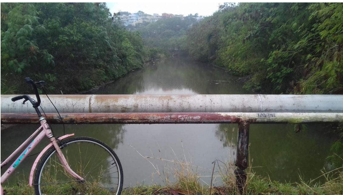
FIGURA 69 - VISTA DA PONTE DO CANAL DE CAMBOATÁ
