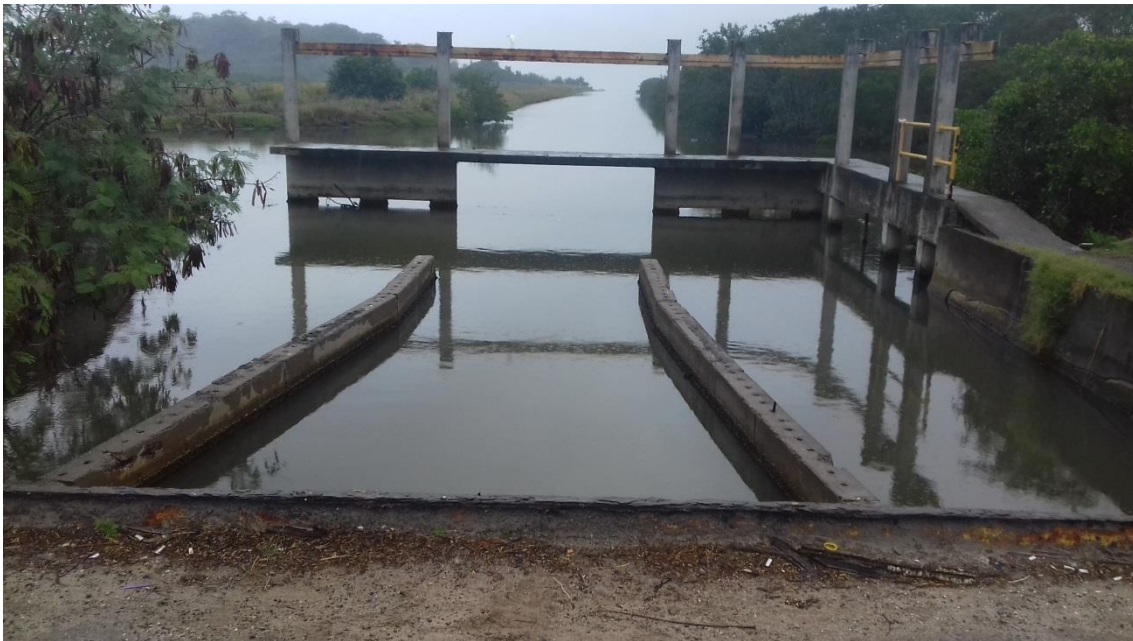
FIGURA 62 - COMPORTAS DO CANAL DE CAMBOATÁ ENTRE A LAGOA DE PIRATININGA E A LAGOA DE ITAIPU
