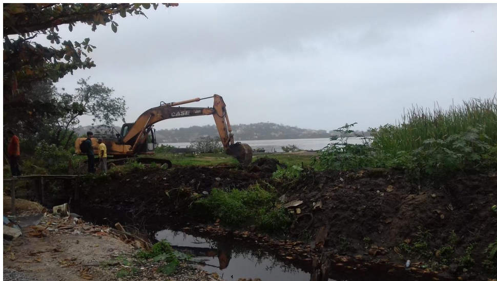
FIGURA 18 - DRAGAGEM DO CANAL DE CINTURA DEVIDO AO ASSOREAMENTO E ACÚMULO DE RESÍDUOS SÓLIDOS
