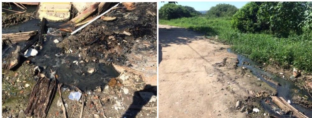
Figura 10-A, 10-B: Vazamentos de esgoto da rua para o canal.
