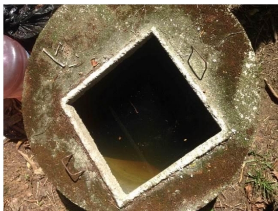
Figura 34: Imagem do poço mais a sul, próximo à entrada do Sítio e com cota de 113,85m. O poço por vezes é recarregado artificialmente.
