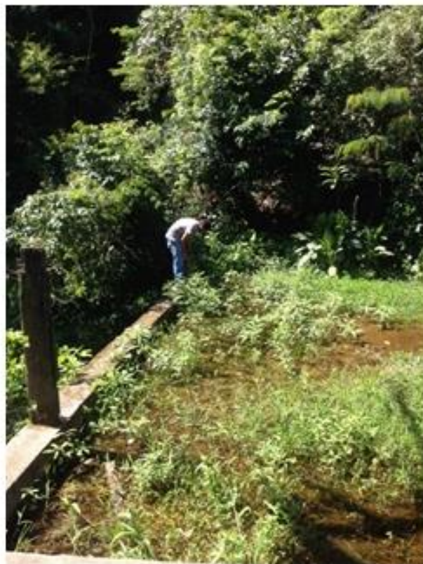
Figura 22: Barragem no leito do rio localizada na Hípica.
